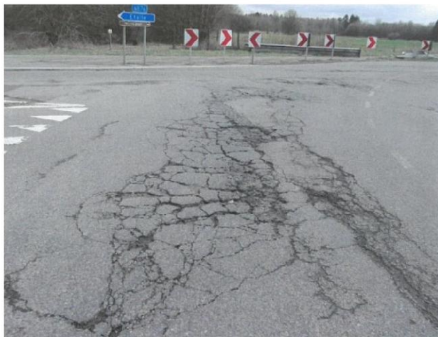
Vue du contournement au niveau du carrefour avec la rue de Virton (RN87).
