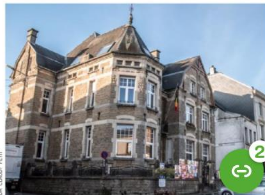
Nouvelle décision de la Commune d'Étalle annulée par le ministre des pouvoirs locaux.
